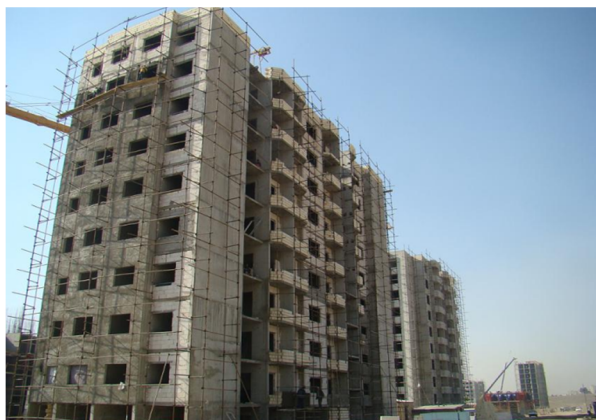
شکل (۱): نمونه‌ی ساختمان‌های قالب‌تونلی احداث‌شده در ایران (پروژه ۲۵۳۰ واحدی پردیس بومهن)
