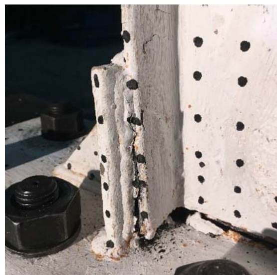
شکل (۳۱): آسیب در جوش بال تیر به ورق زیرسری.
