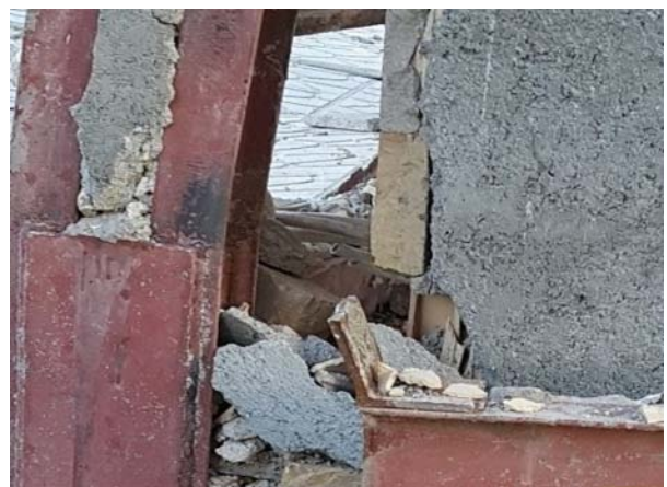
شکل (۱۰): آسیب در اتصال نشیمن ساده به همراه سخت‌کننده.
