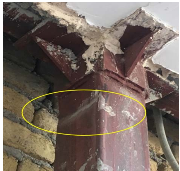
شکل (۹): کمانش موضعی در ستون.
