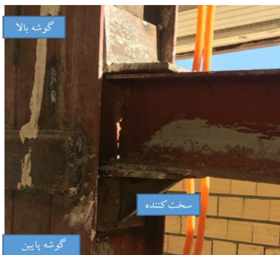
شکل (۸): نمایی از اتصال نشیمن ساده به همراه سخت کننده.
