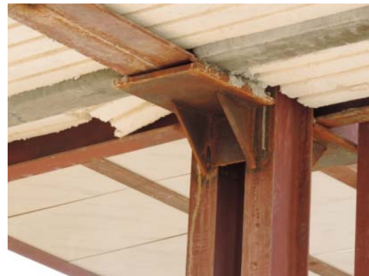
شکل (۵): نمایی از ورق زیر سری به همراه سخت کننده‌ها.
